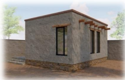
شکل ۷: مرحله هسته اولیه با مصالح ساختمانی خشت پخته، خشت خام و سنگ و گابیون البته بر اساس معیارهای دسترسی به مصالح ساختمانی و هزینه آن، ممکن است در بعضی مناطق کشور بهترین گزینه ساخت مسکن تدریجی، استفاده از خشت خام و گِل، سنگ و گابیون و یا مصالح دیگر مناسب‌ترین گزینه باشند.
