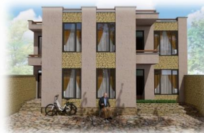
شکل ۸: مرحله تکمیل شده مسکن تدریجی با مصالح خشت پخته، خشت خام و سنگ و گابیون
